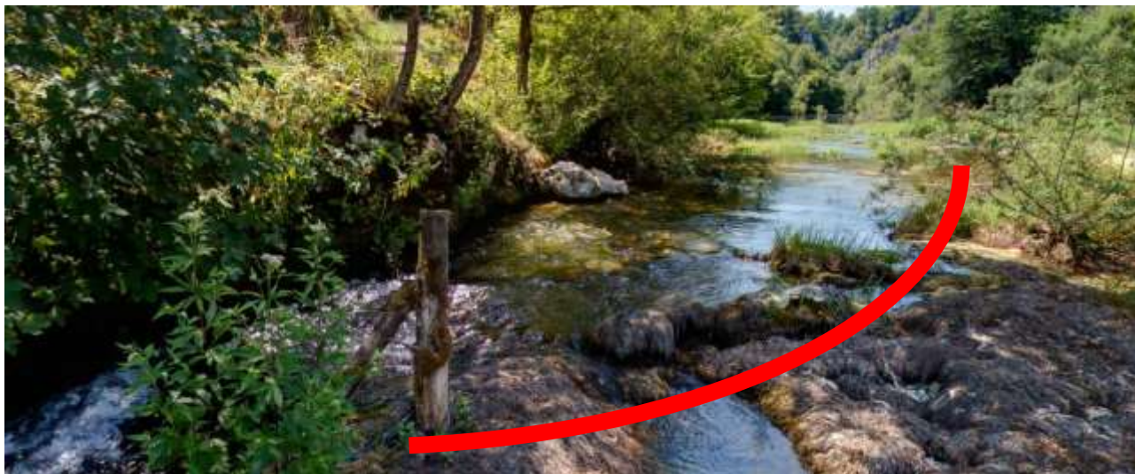
Slika 3.1.-3. Vizura uzvodnog toka rijeke Mrežnice na lokaciji kamenog zida unutar korita rijeke. Crvenom linijom označena je okvirna pozicija bivšeg funkcionalnog zida koji se planira obnoviti kao vodozahvat
