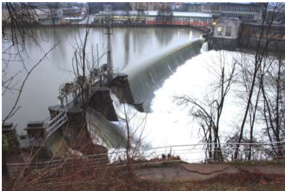
Slika 2.2-1. Mala hidroelektrana Pamučna industrija Duga Resa
